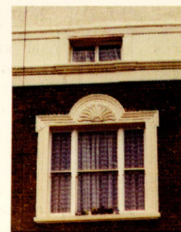
13 Nos 407-419 Mare St.
